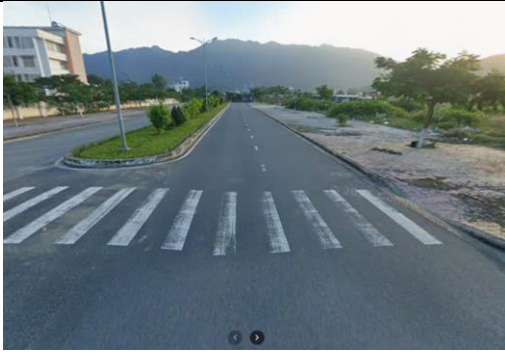
Hình 7. Tuyến đường D3
